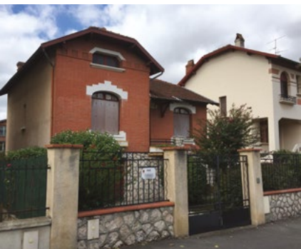
Façade côté rue avant les travaux.
